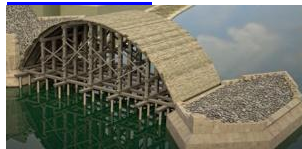
Karlův most - Stavba pilíře a klenebního pole ve 14. století - video 2:59
